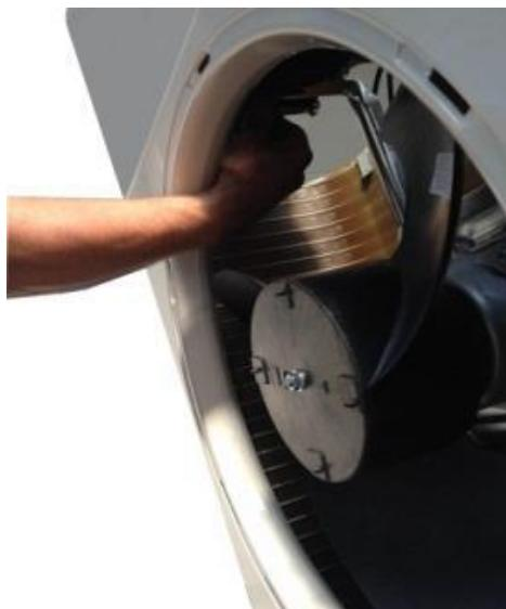
На рисунке: доступ к сливному клапану снизу через крышку вентилятора (смотреть на тепловой насос слева).
